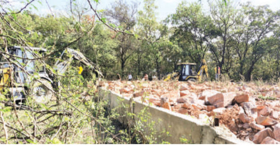
एफटीएल क्षेत्र में आ रहे निर्माण कार्यों को ढहती जेसीबी।
